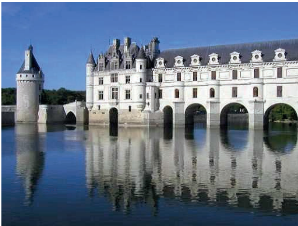
Detalle de la galería sobre el río Cher del Castillo de Chenonceau
