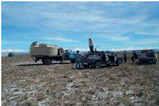
Instalando uno de los tanques
